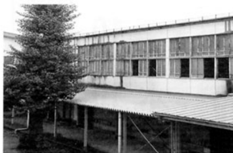
屋根の修繕工事がなされた旧体育館
